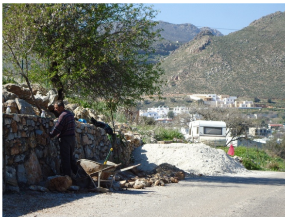
Εικόνα 3: Επιδιόρθωση αναλημματικού τοίχου αναβαθμίδας στην Τήλο. (Φωτο: Χ. Χρυσανθάκη).
