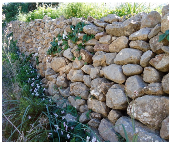
Εικόνα 1: Αναλημματικός ξερολιθικός τοίχος αναβαθμίδας στην Τήλο (Φωτο: Χ. Χρυσανθάκη).
