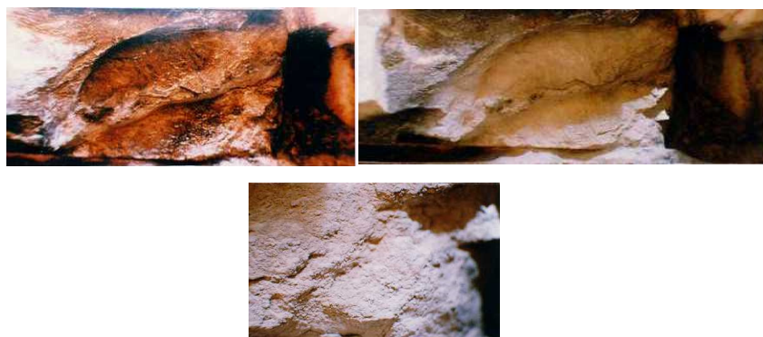
Σχήμα 2. Σταδιακή αποκατάσταση της γυψοποιημένης επιφάνειας
